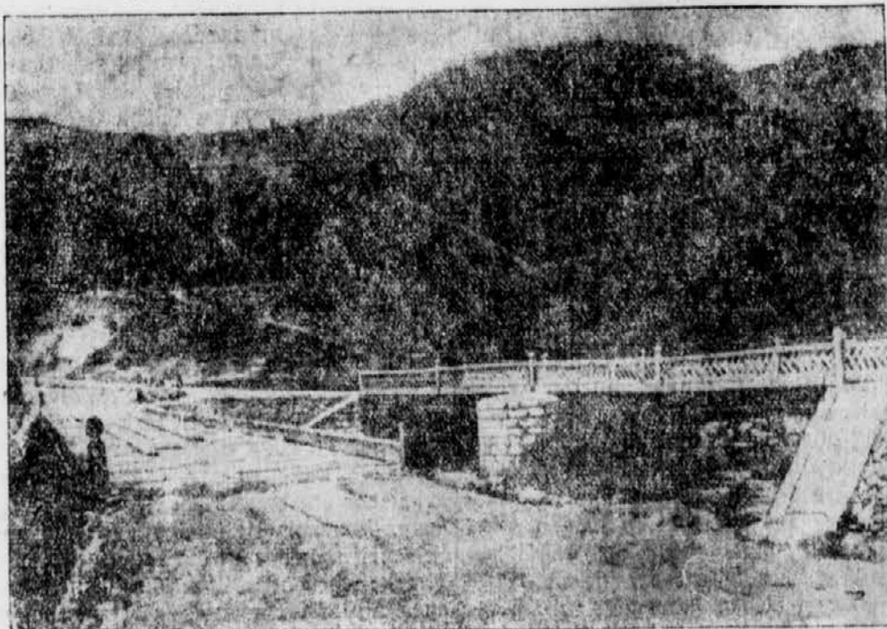
Chinesische Ingenieure erbauten an wichtigen Stellen der Burmastraße Brücken in doppelter Ausfertigung, da sie mit dem starken Angriff der japanischen Luftwaffe auf diesen wichtigen Verbindungsweg rechneten. — Unser Bild zeigt eine dieser Brücken in doppelter Ausfertigung auf der Burmastraße
