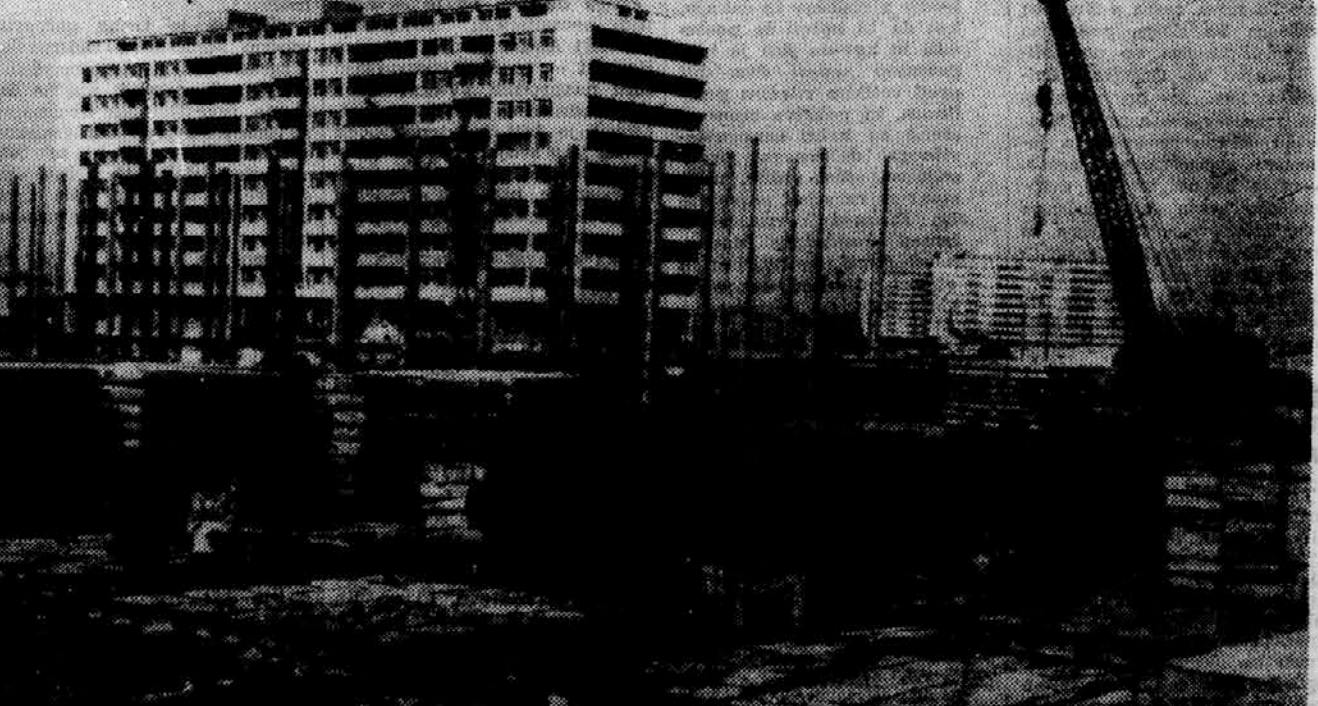
Stanovanjski izgradnji poveča predlog društvenega plana za leto 1963 veliko pozornost. Na sliki: montažna graditev stolpnice v Novem Beogradu.
