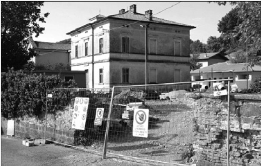
Gradbišče v Pevmi sameva
