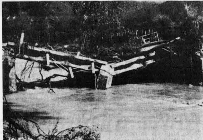
Most čez Ter pri Nemah se je zaradi hudega neurja porušil
