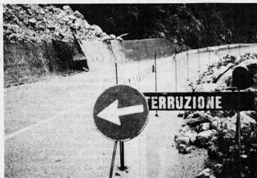
Močno poškodovana in težko prevozna je cesta tudi na mostu v Ahtnu
