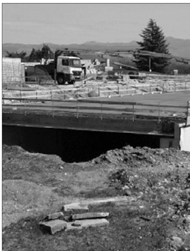
Avtocestno gradbišče pri Sovodnjah
