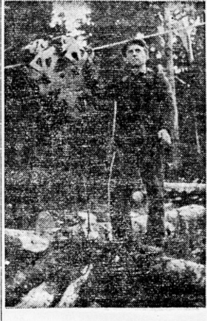
Udarnik Lojze Rakar iz Breginja, strokovnjak v montiranju gozdnih žičnic. Na žici nosilki je transportni vozček naše najmodernejše žičnice.
