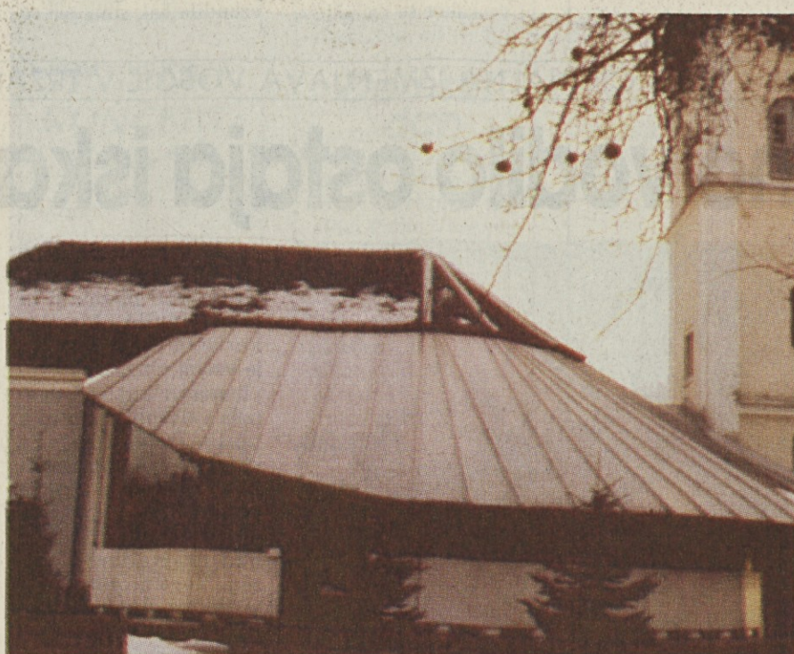
Slika 3: Leta 1976 se vedno ideajloško »sporna« prenova cerkve v Reticah (arhitekt Jugovec je zanj prejel Presernovo nagrado)
