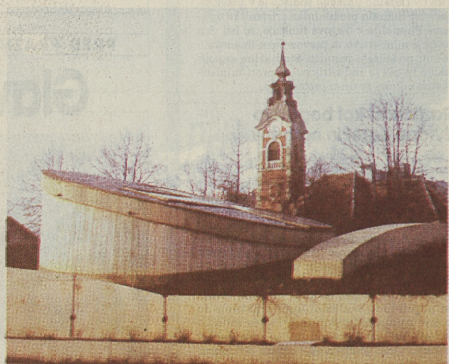
Slika 4: »Prenova« cerkvice Sv. Roka v Dravljah z dodano novo, moderno arhitekturno zasnovo (arhitekt Marjan Music, 1985)
