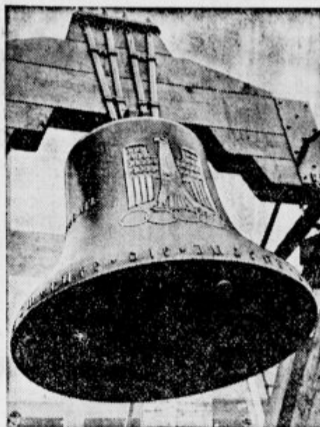
Veliki olimpijski zvon, ki so ga ulili, da bo zvonil na berlinski olimpijadi, ima 2,80 m premera ter je z jarnom 2,70 m visok. Z jarnom tehta 13.840 kg.
