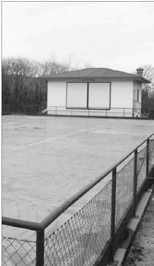
Kotalkališče društva Vipava na Peči čaka na novo kotalkarsko ploščad in na streho
