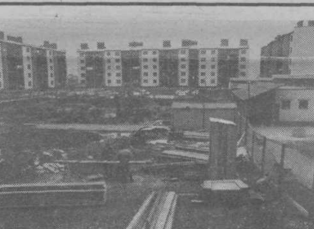
Gradnja prizidka k vrtcu v Novih Jaršah
