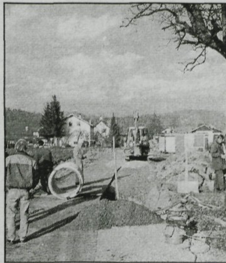
V Loka smo v decembru nadaljevali z izgradnjo kanalizacije Na Gmajni v izvajanju VGP iz Ljubljane. foto: M. Ogrinc
