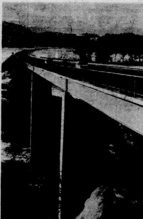
Viadukt Peračica na Gorenjski avtocesti
