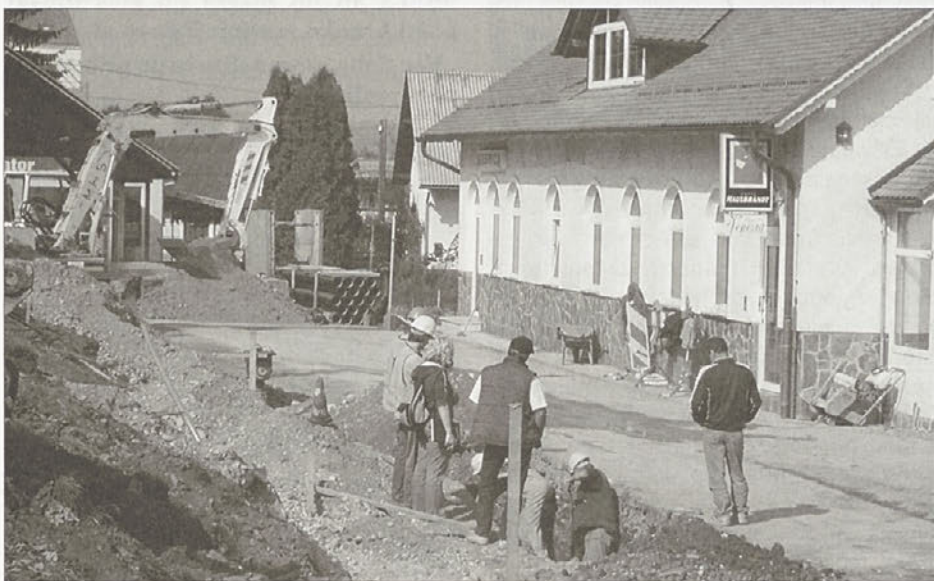
V centru Hajdine potekajo dela pri položitvi kanalizacije.
