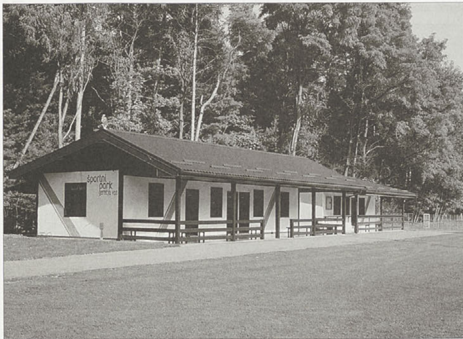
Obnovljeni objekt ob igrišču v Gerečji vasi
