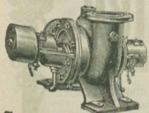
**Nieder- und Hochdruck-Zentrifugalpumpen**
