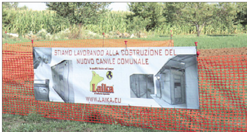
Gradbišče novega pesjaka pri Ločniku
