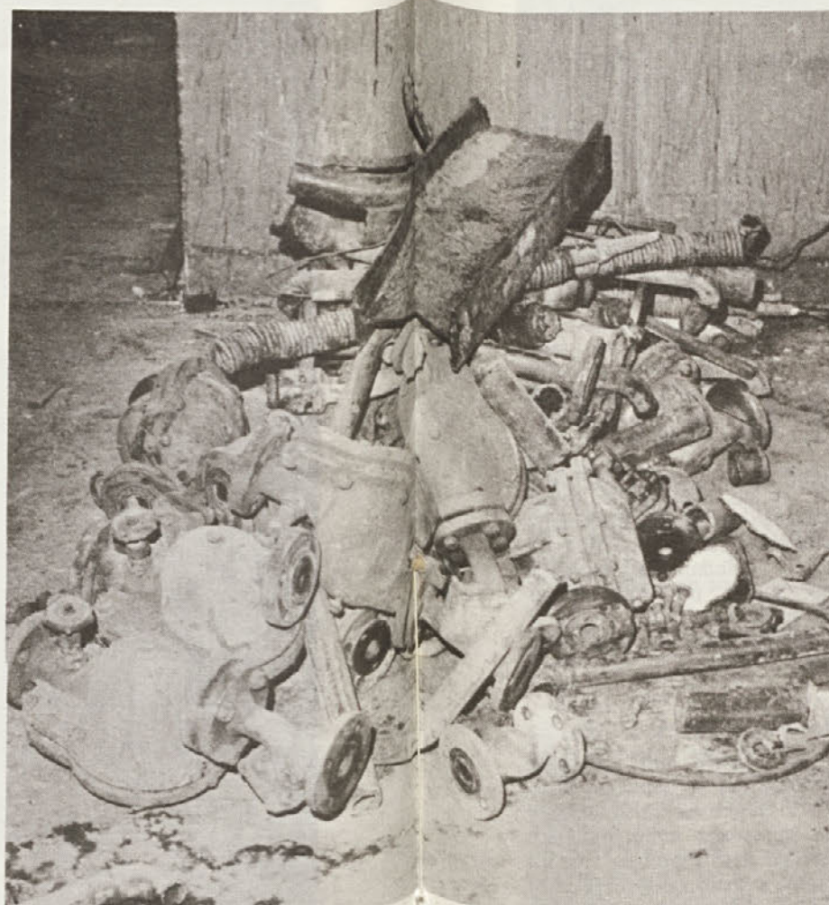
To je le del zamenjenih ventilov
