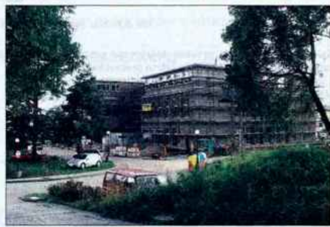
Drugo nadstropje preddvorske šole je že zgrajeno.
