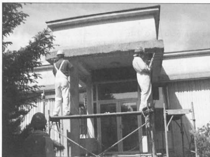
Sanacija razpok v betonskem stropu.
