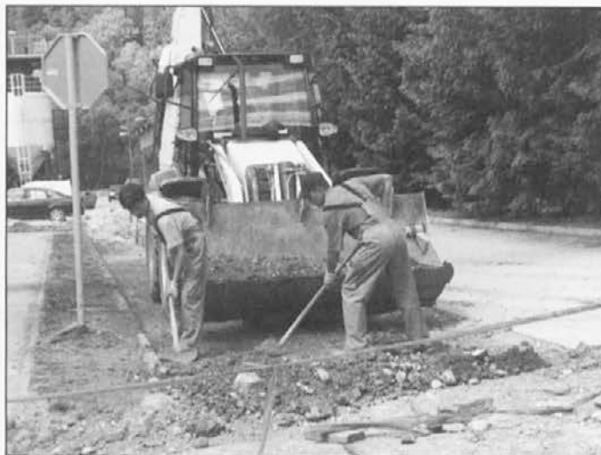
Za gradbena dela je treba izkoristiti vsak lep dan.
