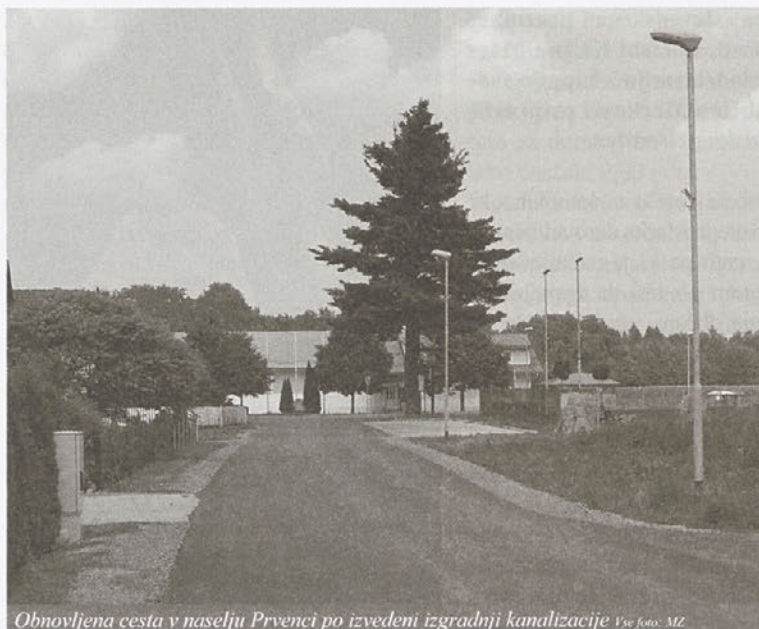
Obnovljena cesta v naselju Prvenci po izvedeni izgradnji kanalizacije. Vse foto: MZ
