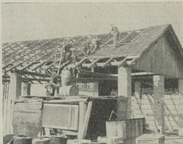
Prestavitev »šupe« za zaboje in les. Podiranje se prične tam, kjer se gradnja konča
