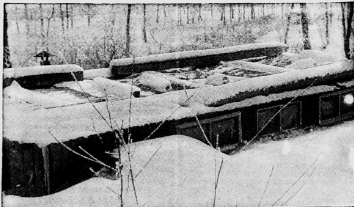
Posnetek z nemškega bojišča ob Renu. Betonske utrdbe so pod snegom, kateremu bodo v kratkem sledile poplave
