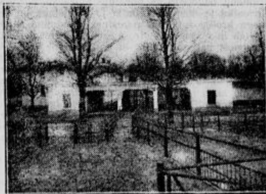
Klavniška klančina (rampa) s modernimi hlevi.
