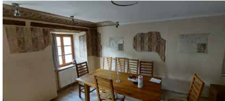
Med obnovo odkrita stenska poslikava v notranjščini hiše Mestni trg 3 v Višnji Gori.
