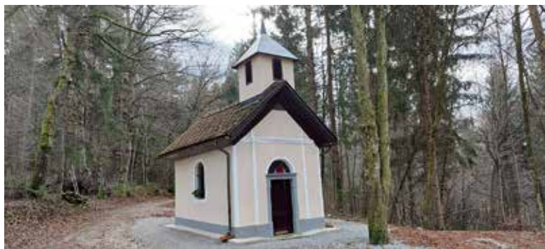
Pintarjeva kapelica na Čagoškem hribu z novo fasado.
