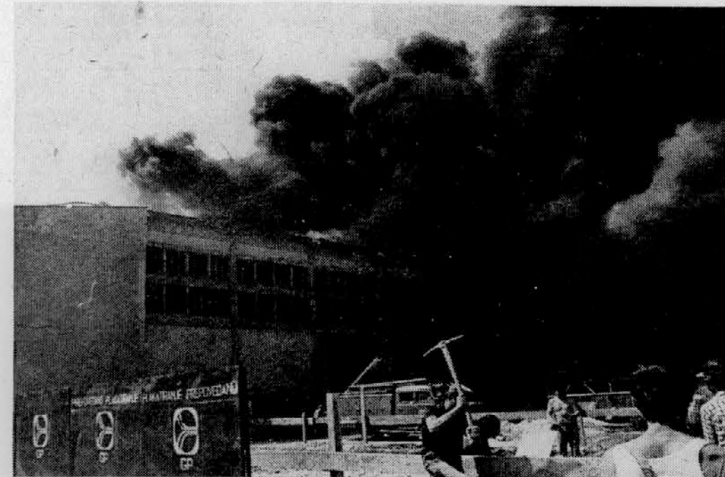
Streha centralnih delavnic ŽG Ljubljana v plamenih
