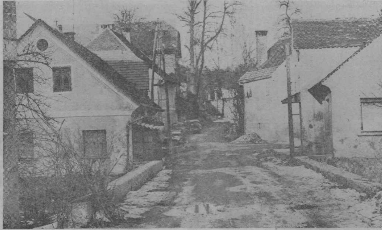
Tudi cesta Stare Črnuče je prišla na vrsto za asfalt. Kanalizacijo so uredili že lani
