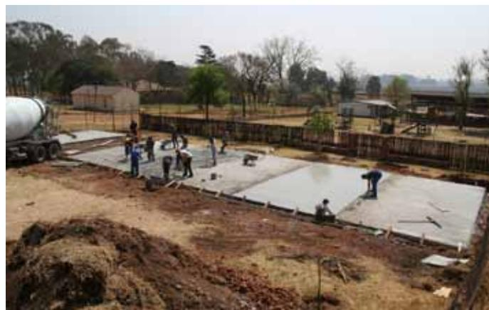
Slika 1: Knjižnica in učilnica, 2010: betoniranje talne plošče.
