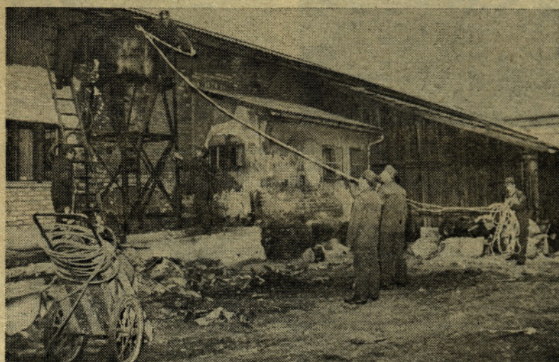
Tehnično-reševalna enota izvršuje predpriprave za rušenje silosa, ki je ogrožal okolico. Člani te enote nimajo lahke naloge, vendar so dokazali na vaji, da so dobro pripravljeni.
