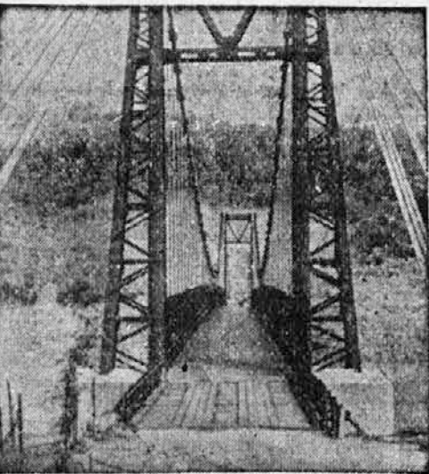
Birmanska cesta, po kateri pošiljajo Angleži svojo pomoč maršalu Čankajšku, se ponaša tudi s slikovitimi deli najodličnejše tehnike. Speljana je po visokem gorskem svetu, kjer so čez prepade in globoke struge gorskih hudournikov zgrajeni veliki železni mostovi, kakršnih enega kaže tale slika.
