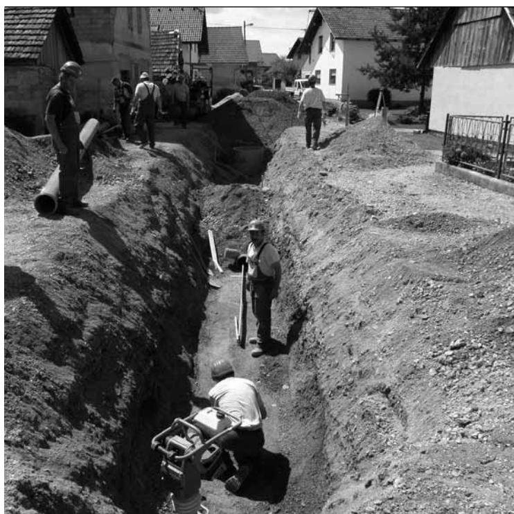
Izgradnja kanalizacije v Iški Loki
