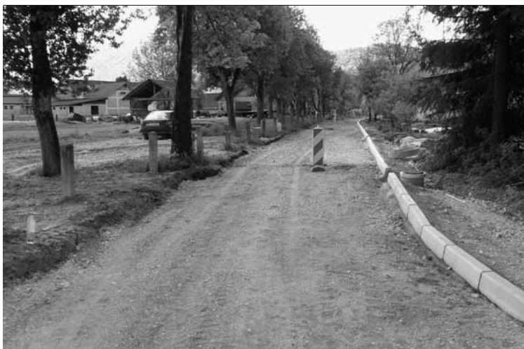
Priprava podlage za asfaltiranje v Mateni
