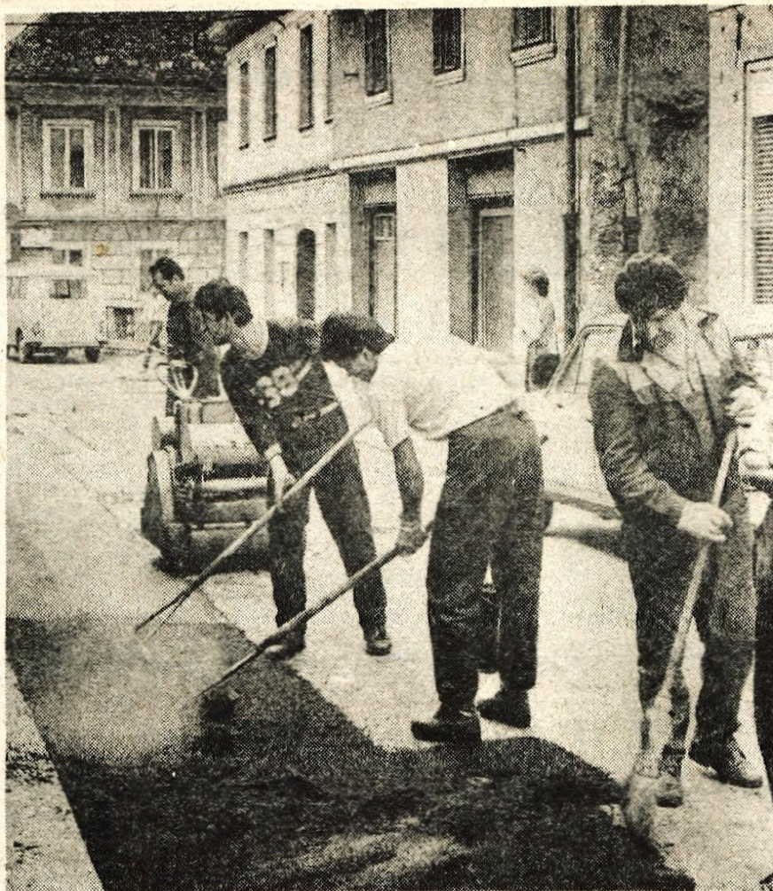
»Kranje« Cankarjeve ulice — Asfalt v Cankarjevi ulici, v starem delu Kranja, je bil v zadnjem času precej dotrajan. V programu samoupravnih komunalnih interesne skupnosti občine Kranj je tudi vzdrževanje ulic. S temi sredstvi so pred nedavnim obnovili asfaltno prevleko v Cankarjevi ulici in na asfaltiranem delu Trubarjevega trga. Dela je opravilo Komunalno obrtno gradbeno podjetje Kranj. — A. Ž. — Foto: F. Perdan
