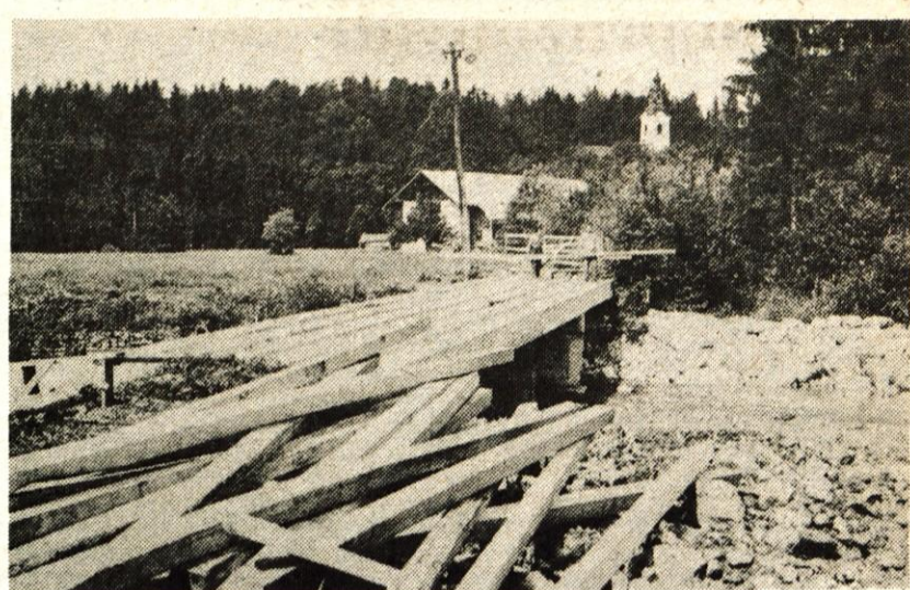
Breg ob Kokri — Delavci Vodnogospodarskega podjetja iz Kranja so 20. junija pričeli graditi 34 metrov dolg in pet metrov širok betonski most čez Kokro, ki bo povezoval vasi Tupaliče in Breg. Most bo zanesljivo naredil do kranjskega občinskega praznika, 1. avgusta, veljal pa naj bi 3,5 milijone dinarjev. — Foto: C. Zaplotnik
