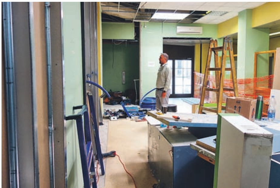
Prenova sanitarnih prostorov, prostorov za odvzem krvi in administracije intenzivno poteka. Radi bi jo zaključili čim prej.
