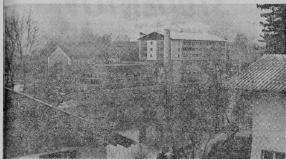
Pogled na novi hotel in zaprti bazen zdravilišča v Laškem
