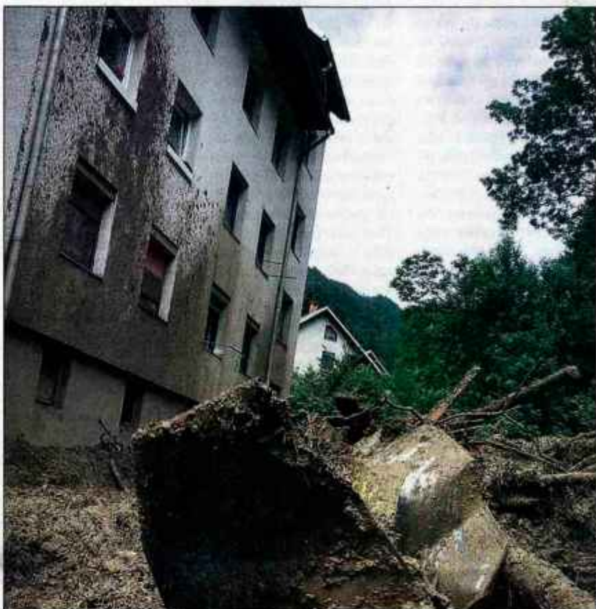
Sledovi zemeljskega plazu segajo do drugega nadstropja stanovanjskega bloka Ravne 23, 24.
