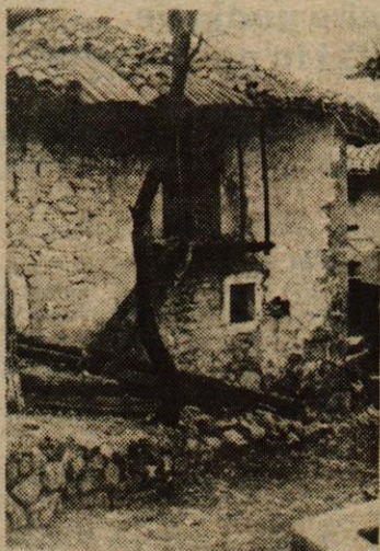
Zdaj zdaj se utegne zrušiti (dobro je vidna struktura kamnitega zidu — opeka je draga, kamna pa je zadosti).
