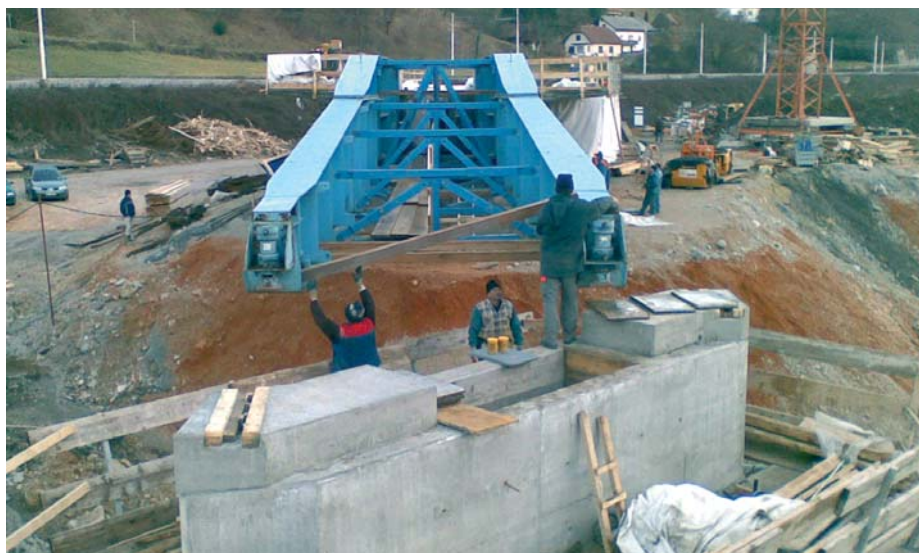
Slika 5 • Prihod kljuna na steber v osi 5
