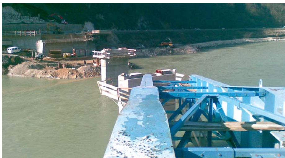
Slika 6 • Pogled preko kljuna v smeri narivanja
