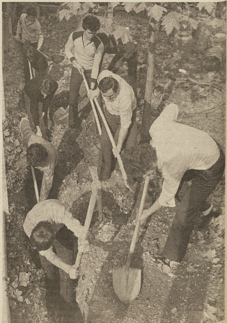
V TOZD TELA so imeli konec preteklega meseca delovno akcijo. Na pobudo mladinske organizacije in s podporo vodstva je pri izkopu kabla v dolžini ca. 90 m od galvanike do menze in izkopu 16 m utrjenih tal sodelovalo približno 40 članov kolektiva.
