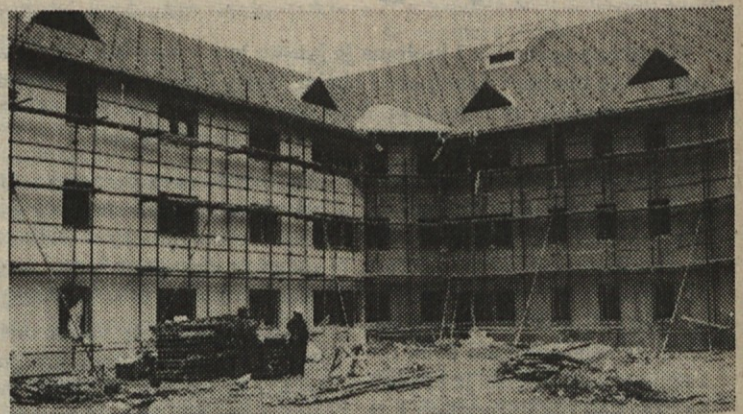
Gradnja zavoda za prizadete otroke dobro napreduje.
