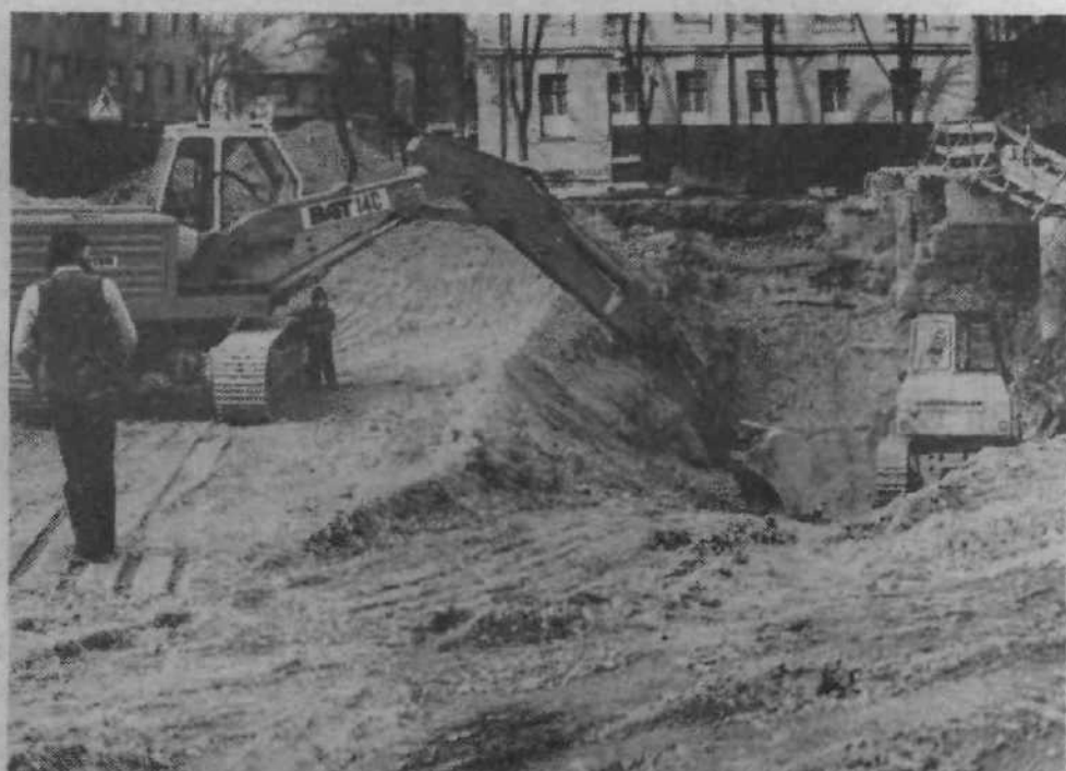
Pred poslovno stolpnico Petrola so se gradbeni stroji zajedli v zemljo na mestu, kjer je nekoč stala postaja milice. Pričeli so z izkopi za dokončno ureditev kolektorja z vsemi napeljavami. Ko bo delo opravljeno, bodo površino asfaltirali in na njej uredili parkirne prostore tako, da bodo vsaj delno odpravili prometni infarkt na tem delu Titove ceste. Tako so opustili zamisel starega zazidalnega načrta, po katerem naj bi na tem mestu uredili prepotrebno zelenico.
