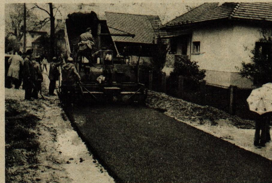
ASFALTIRANJE V STRAŽIŠČU - V krajevni skupnosti Stražišče je začelo Cestno podjetje iz Kranja pretekli teden asfaltirati krajevne ceste, pota in ulice. Vgrajevanje asfalta je prve dni oviralo slabo vreme. Kljub temu delo dobro napreduje. Denar za asfaltiranje zbirajo prebivalci krajevne skupnosti s samoprispevkom. Hkrati z asfaltiranjem urejajo tudi cestno prometno signalizacijo, ki jo kaže upoštevati, saj bo to prispevalo k večjemu prometnemu redu v Stražišču. Ceste so namreč precej ozke in so zato možnosti nesreč večje. (jk) - Foto: F. Perdan
