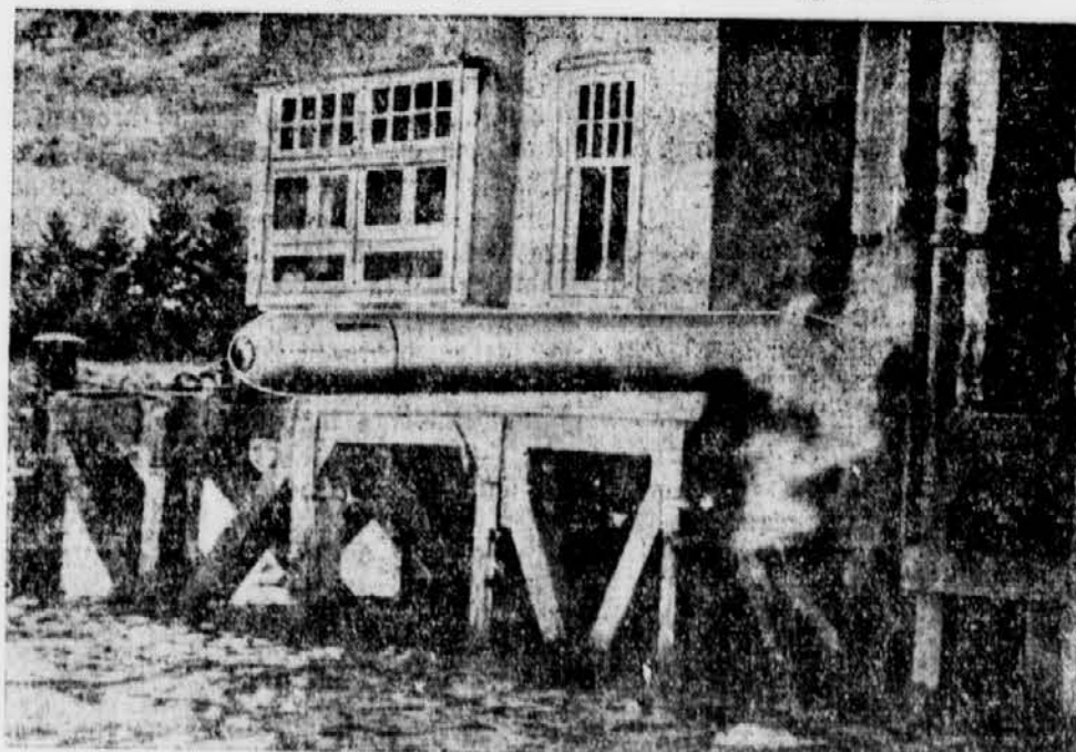
Ein Bild von einem Prüfstand der englischen Marine, auf dem jeder Torpedo vor seiner Ablieferung an die Flotte auf seinen Zustand untersucht wird.
