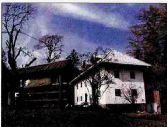
Dom Pristava je po lanskem požaru dobil novo podobo, poškodovani deli stavbe so že popravljeni.
