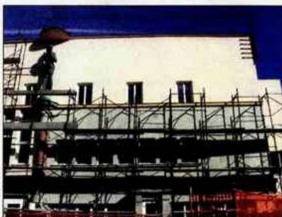
Začela so se nadaljevalna gradbena dela pri urejanju nekot zelo popularnega hotela Korotan.
