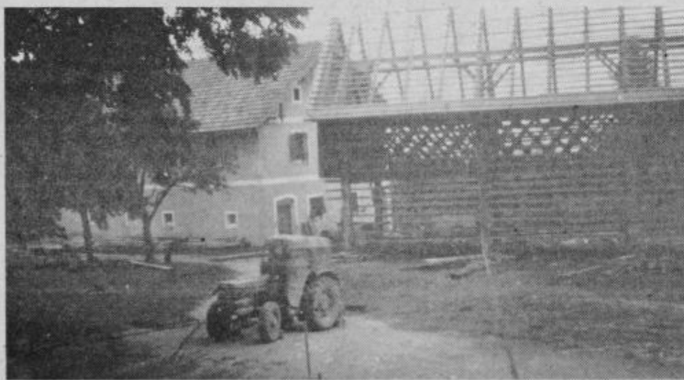
Takole pa so na kmetiji pokazali posluh do ohranjanja starega. Kozolec iz leta 1846, ki je odlično ohranjen, so z mesta, kjer sedaj stoji novo stanovanjsko poslopje, s traktorjem premaknili za 50 metrov, ne da bi ga pri tem razstavili.
