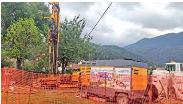
POŠ Iška vas – vrtanje vrtin za geosonde (tri vrtine globine 120 m)
