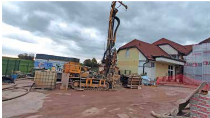
Vrtanje vrtin za geosonde (osem vrtin globine 120 m)
