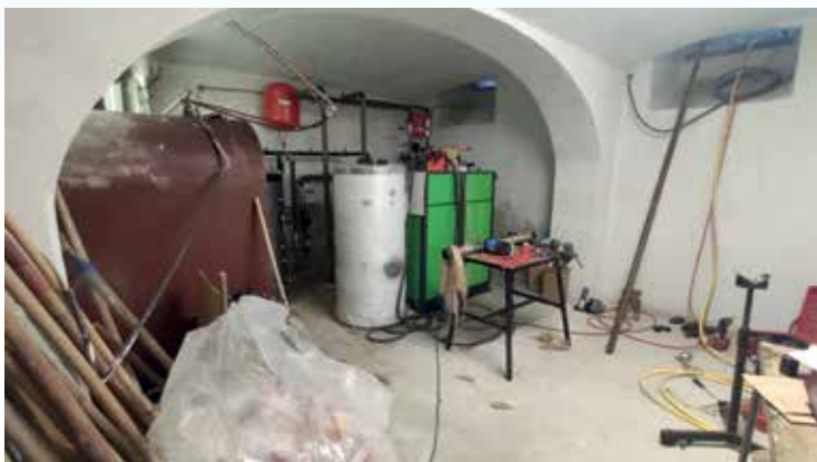
POŠ Iška vas – dela v kotlovnici
