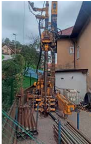
Vrtanje vrtin za geosonde (štiri vrtine globine 120 m)
