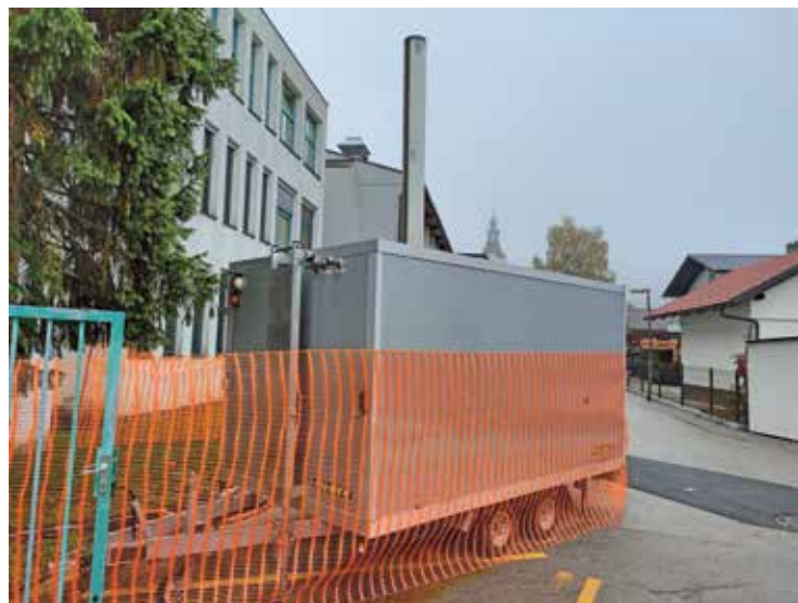
OŠ Ig – mobilna kotlovnica, ki zagotavlja nemoteno dobavo toplote za šolo v času prenove kotlovnice.
