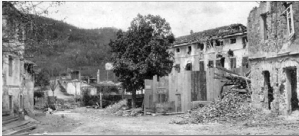
Porušene hiše ob pevmskem mostu
