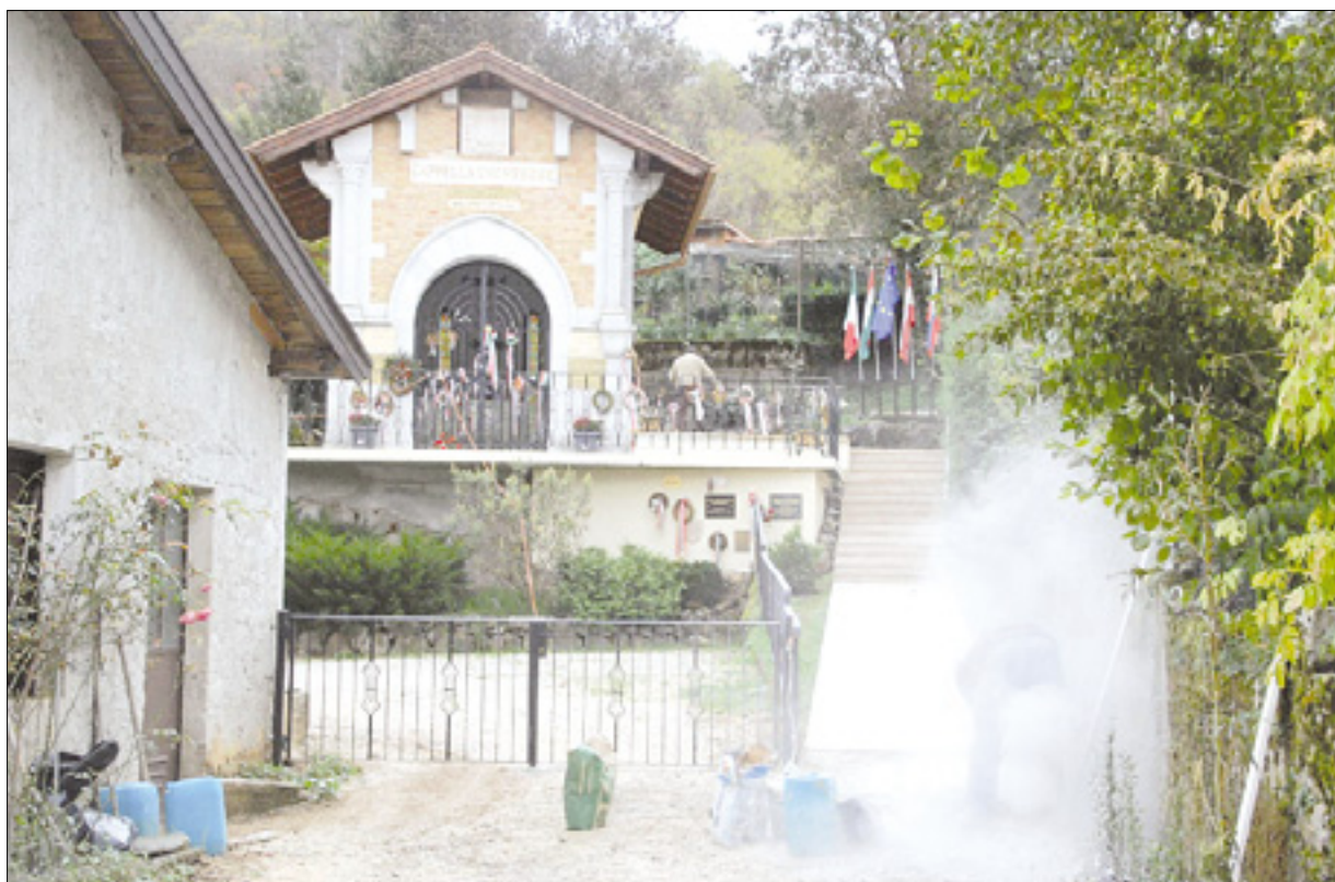
Pred madžarsko kapelico so v polnem teku vzdrževalna dela
