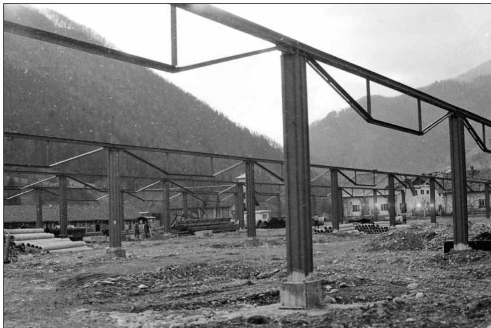
Začetek gradnje Alplesa, avgust 1970. Foto: Blaž Dolenc
