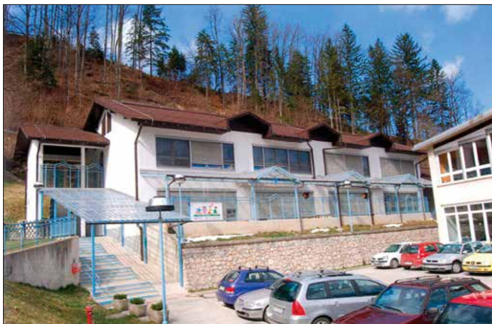
Stavba novega vrtca. Foto: arhiv Vrtca Železniki
