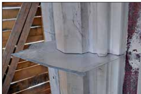
Izdelava šablone za potrebe izdelave kopije uničenega kamnitega elementa (izguba nosilnih lastnosti).
