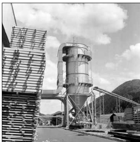
Silos TOZD 3, 1981. Foto: Blaž Dolenc
