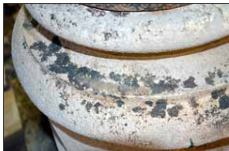
Detajl stebra pred čiščenjem. Lepo vidne obloge, ki so prodrle že globoko v kamenino.
