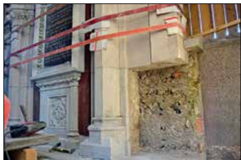
Zahtevna zamenjava uničenih konstrukcijskih elementov grobnice. V tej fazi obnove bi vsaka napaka lahko povzročila tudi porušenje grobnice.
