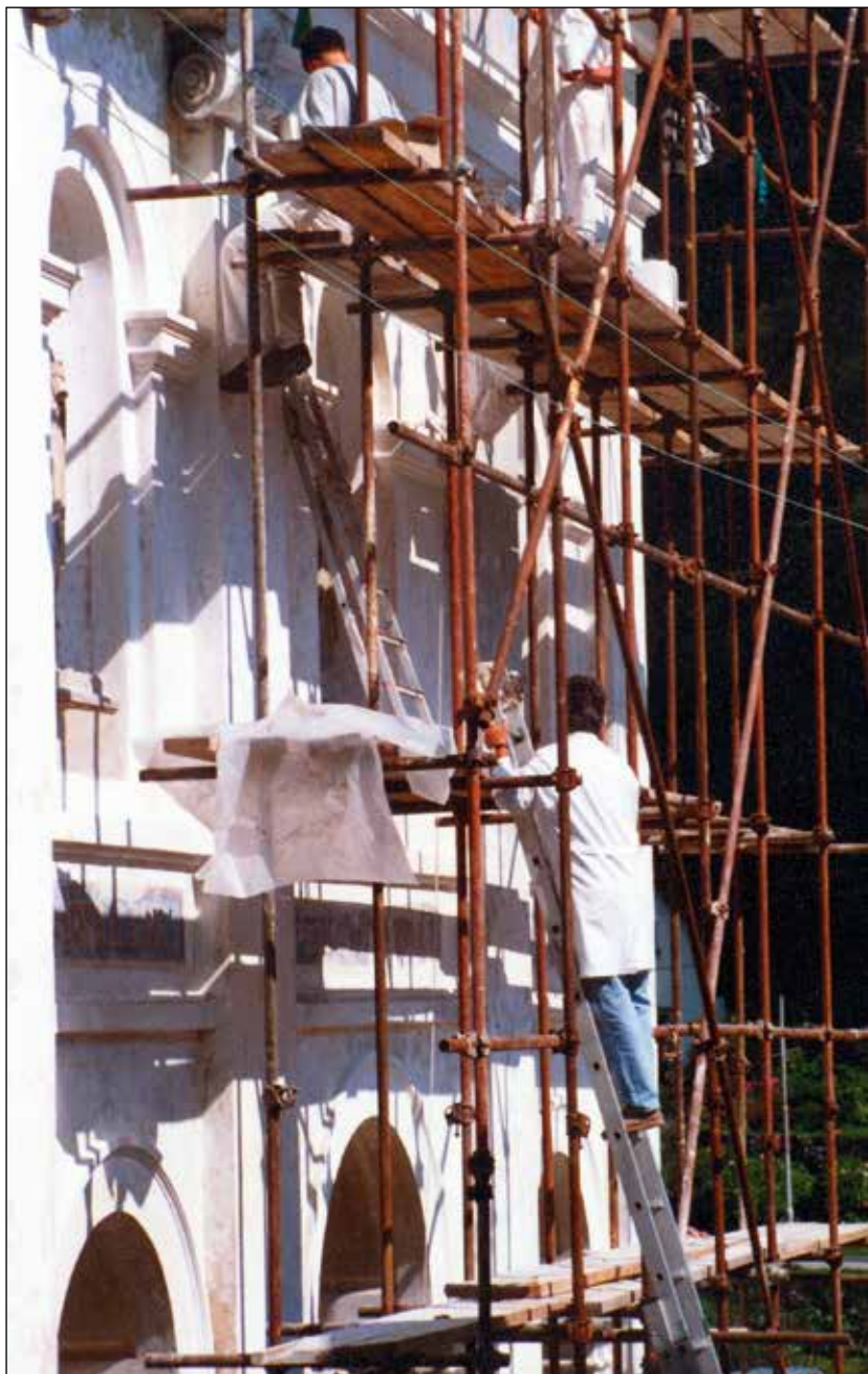
Restavradorji obnavljajo pročelje. Foto: Anton Sedej
