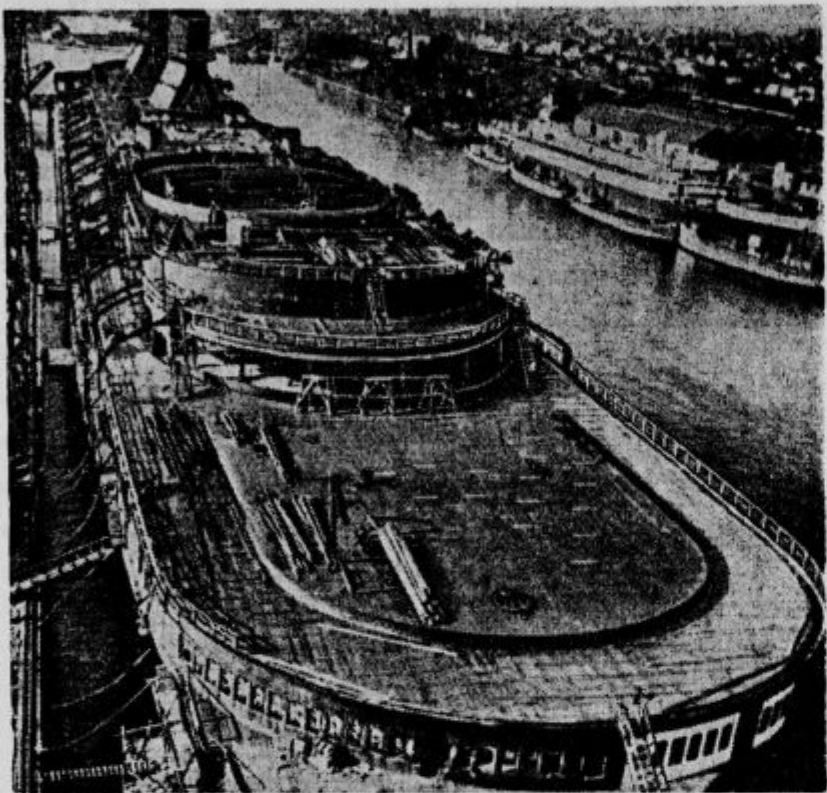
Novi oceanski orjak »Normandien«, na katerem se vrše še zadnja dela. To bo največji francoski preoceanski parnik. Opremljen bo tako razkošno, kakor doslej še nobena ladja. Po zgornjem krovu bo tekla krog in krog celo avtomobilska proga, da bogatašem, ki se bodo vozili na njem, ne bo prehudo dolgčas.
