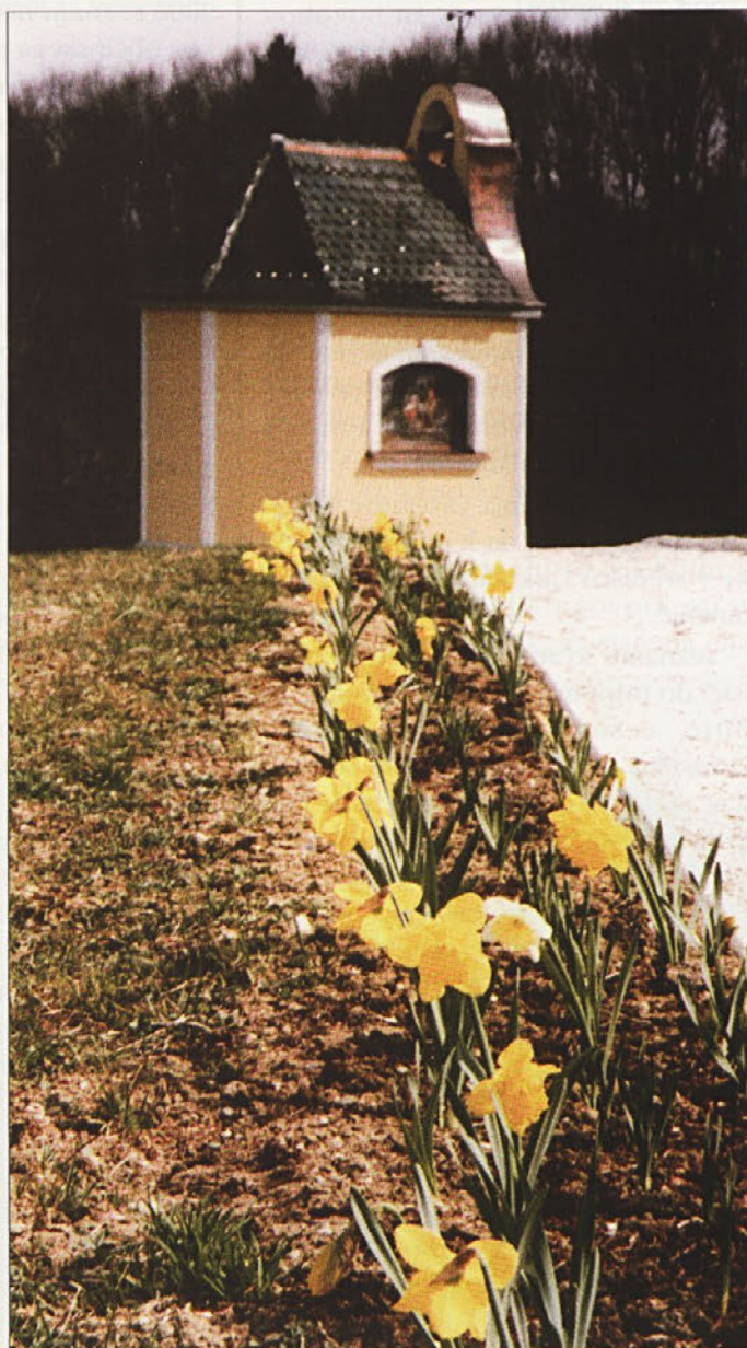
Štuhecova kapela v Gradiščih.
