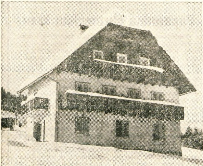
Radojčičevi vili na pobočju Vitrancu v Kranjski gori so dnevi šteti. Občina na Jesenicah jo je že odkupila in jo bodo takoj, ko bo mogoče, podrli. S tem bo smuka na Vitrancu še ugodnejša. Podjetje Gorenjka pa je že lani uredilo teren okrog vile, tako da ga ne bo treba takrat, ko bo stavba že porušena. — Foto: F. Perdan
