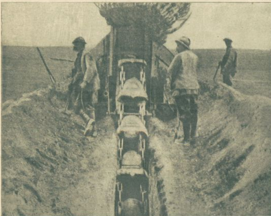
Najnovejši francoski bager-stroj , ki v najkrajšem času izkoplje strelske jarke. Na sliki se razločno vidi, kako napravlja stroj jarek in nasipine obenem.
